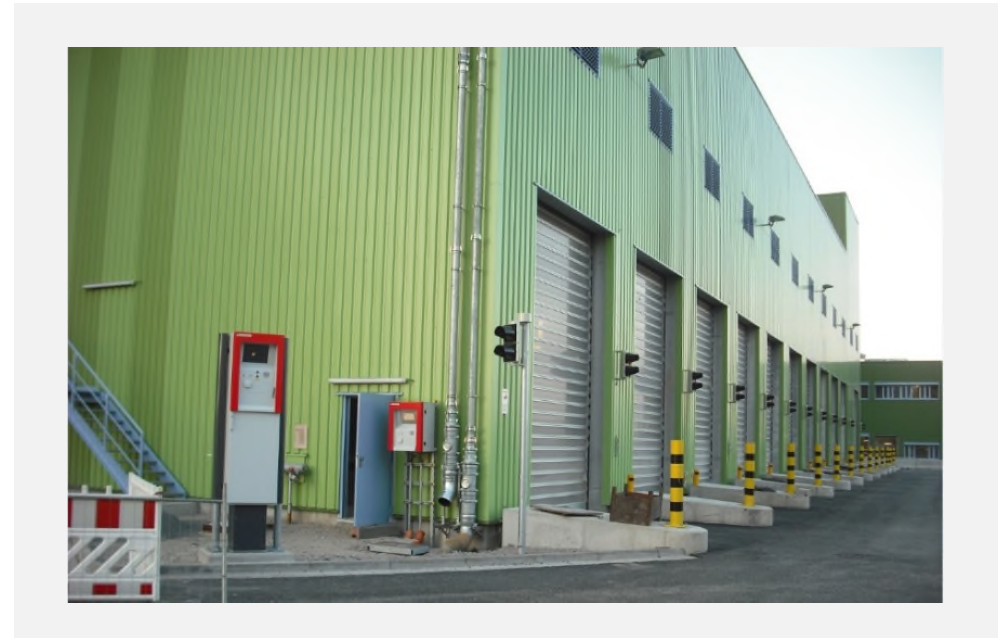
Bild 6: Anlieferhalle der EBS-Anlage (Gebäude H318).
